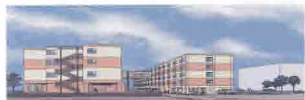
増築部分の完成
